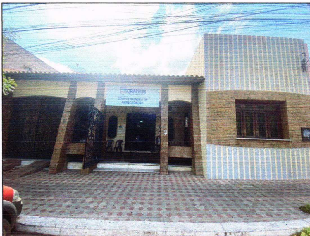
FACHADA DO IMÓVEL DA COORDENADORIA DE ARRECADAÇÃO NA RUA SANTOS DUMONT NO BAIRRO CENTRO, MUNICÍPIO DE CRATEÚS/CE.
