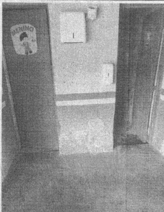
Foto 10-Vista das paredes serem demolidas
