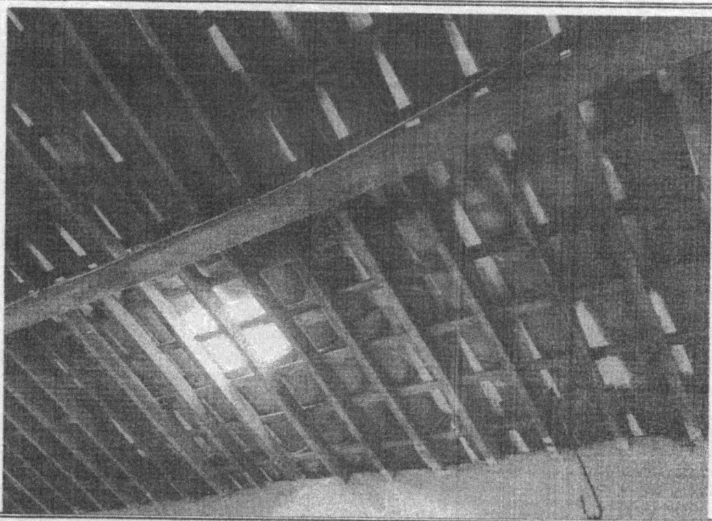
Foto 12- Vista do telhado e substituido a calha
