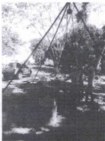
Equipe e equipamento de sondagem a percussão
