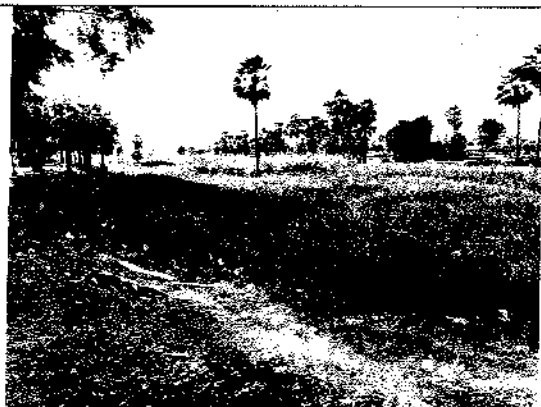
Visão do Local da Construção (1)
