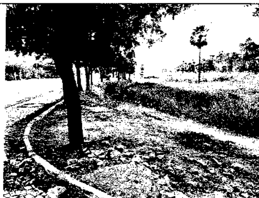
Visão do Local da Construção (2)
