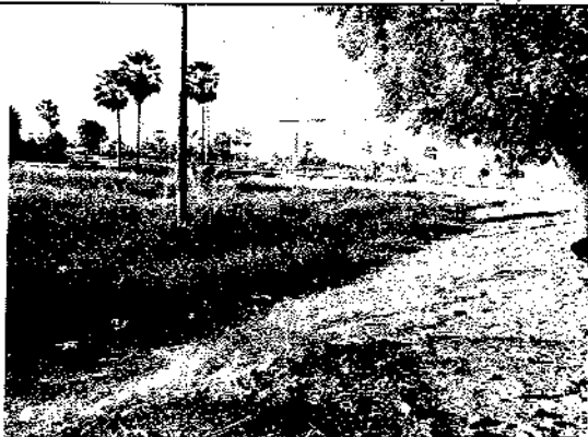
Visão do Local da Construção (3)
