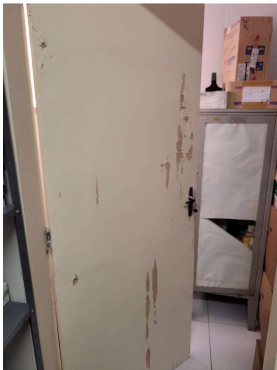
Figura 7 – REVESTIMENTOS DANIFICADOS
