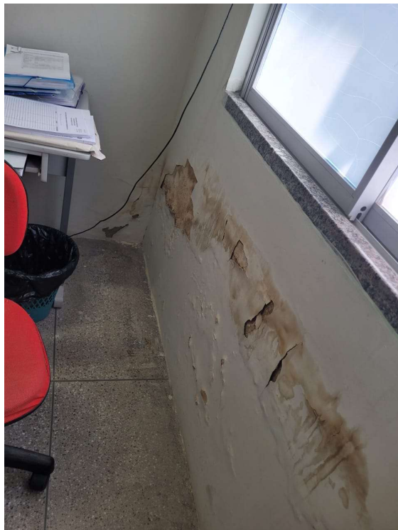
Figura 7 – REVESTIMENTOS DANIFICADOS
