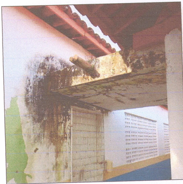
Figura 3 EEB Sebastião G. Martins - Infiltração e bolor.
