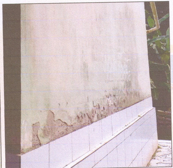
Figura 8: EEB F co J. de Sousa Filho - Revestimento externo.
