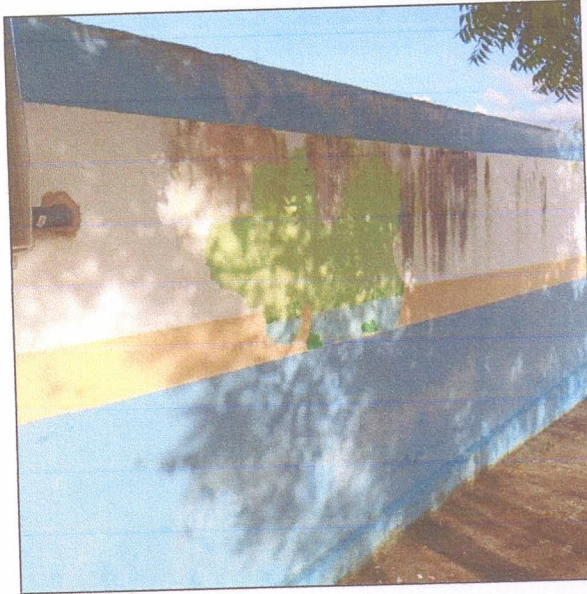
Figura 3 EEB Sebastião G. Martins - Infiltração e bolor.
