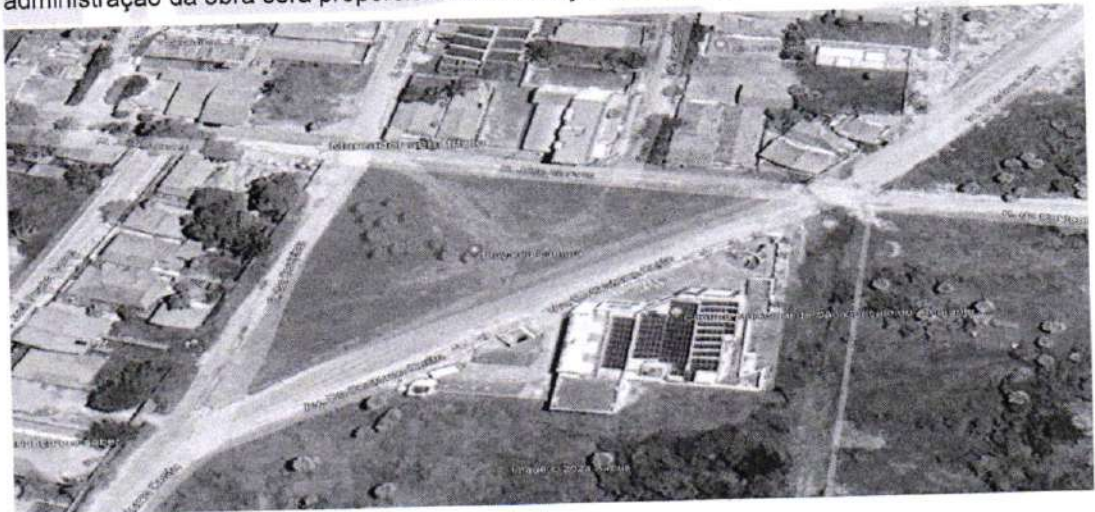
LOCAÇÃO DA OBRA
