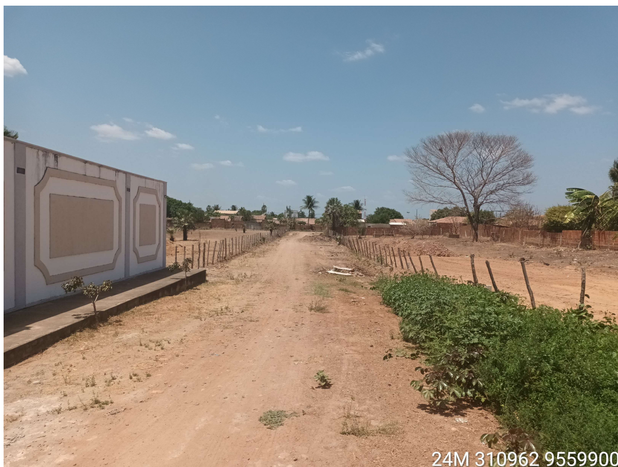
FOTO DO LOCAL DA OBRA
