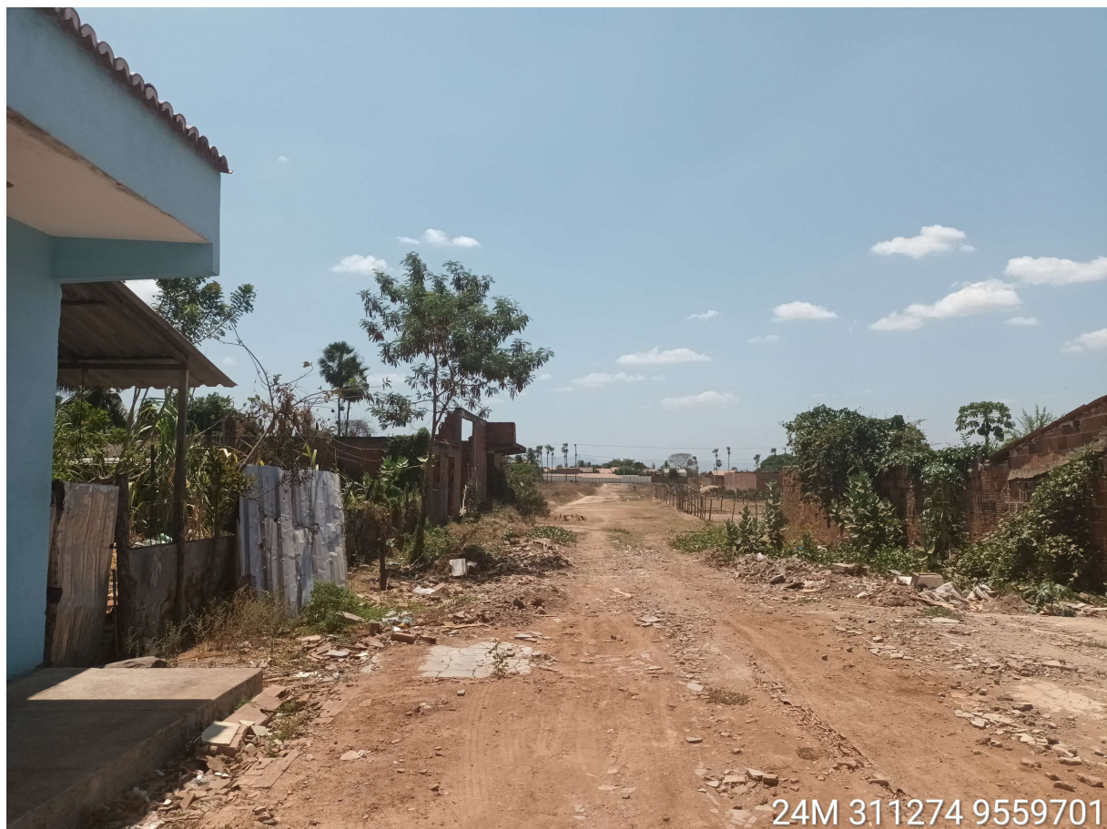
FOTO DO LOCAL DA OBRA
