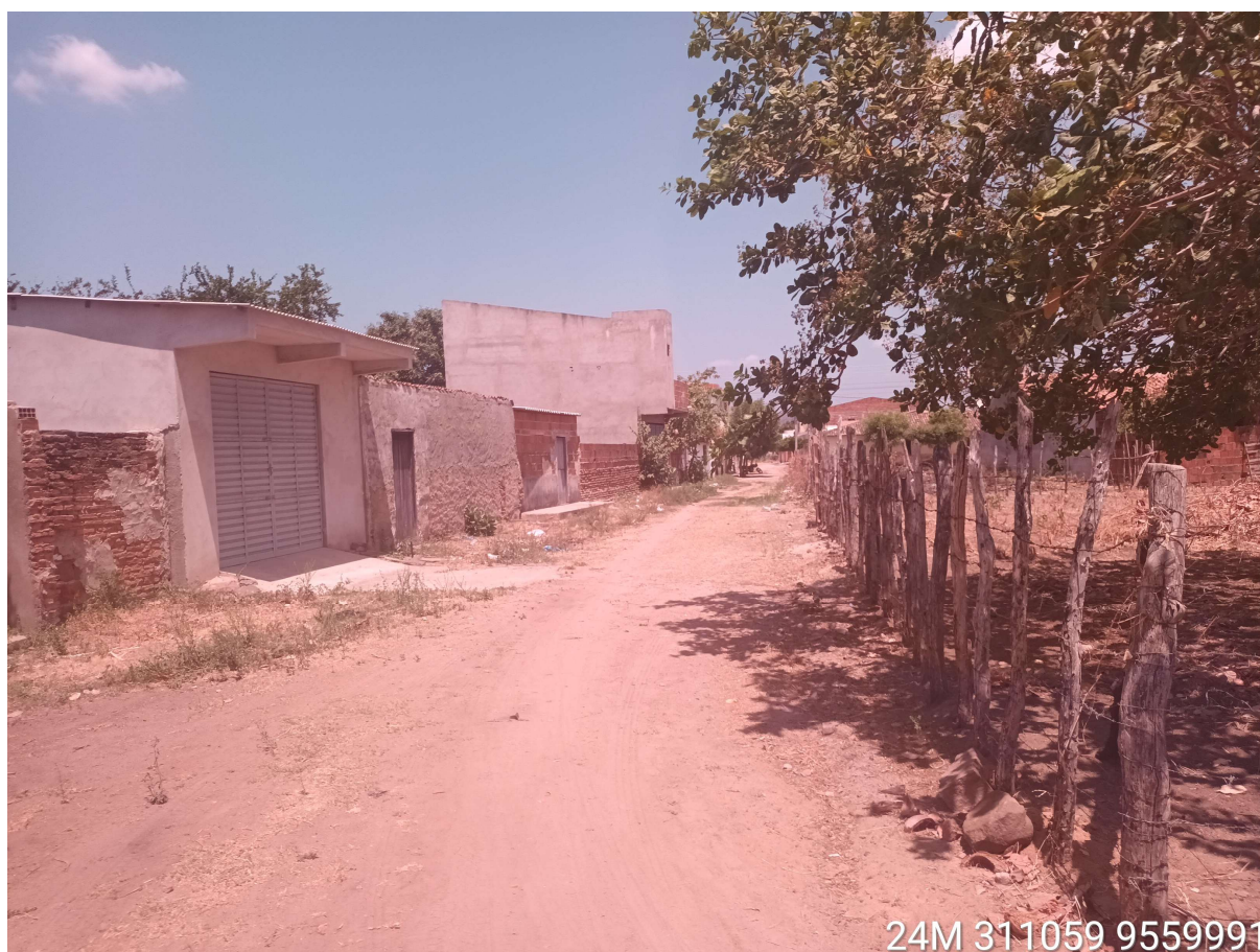
FOTO DO LOCAL DA OBRA
