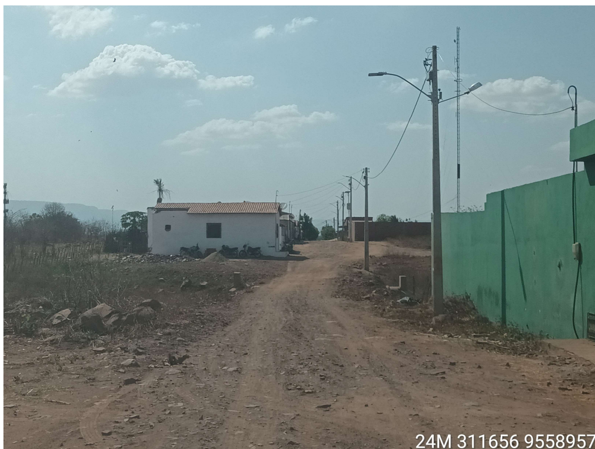
FOTO DO LOCAL DA OBRA
