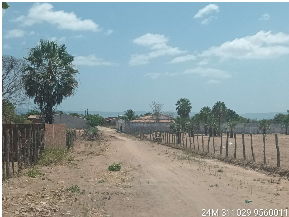
FOTO DO LOCAL DA OBRA
