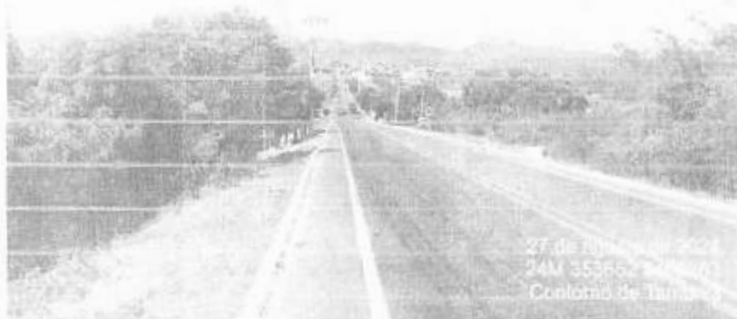
Foto 02 – final do trecho na CE-176, onde foi projetada uma outra interseção em nível.
