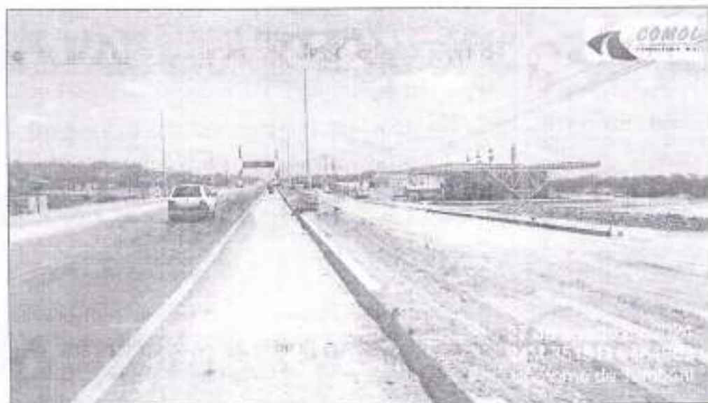
Foto 01 – início do trecho, eixo da CE-266 onde foi projetada uma interseção em nível.
