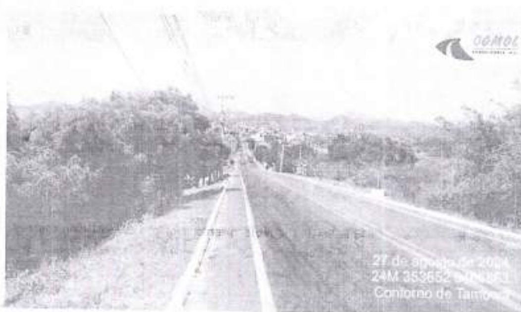
Foto 02 – final do trecho na CE-176, onde foi projetada uma outra interseção em nível.
