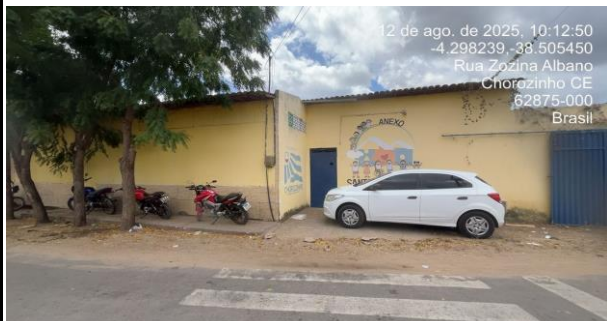
FOTO Nº FACHADA DO PREDIO 3
