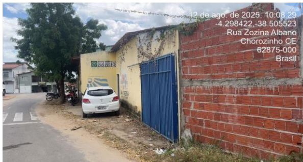
FOTO Nº FACHADA DO PREDIO 1
