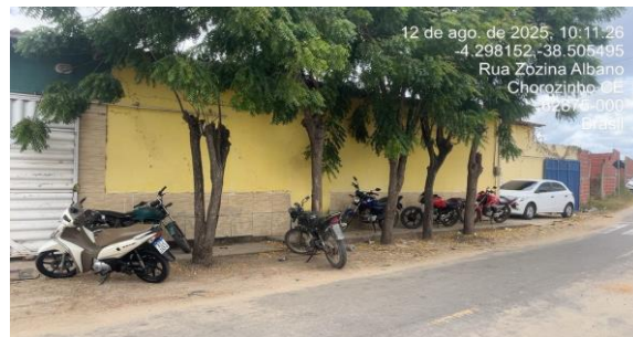
FOTO Nº FACHADA DO PREDIO 4
