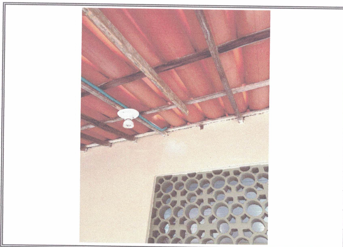
Foto 06- Vista do local que sera substituido telhado
