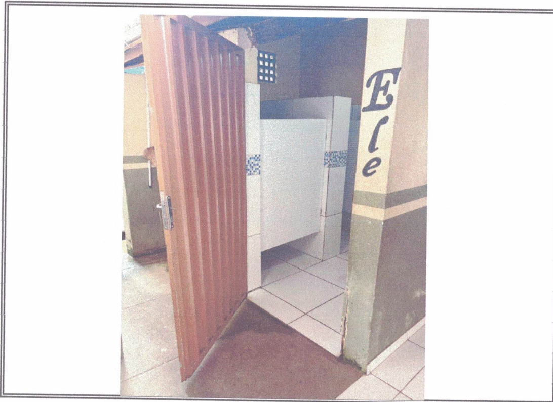
Foto 05 - Vista do local que sera demolido wc
