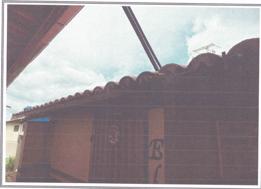
Foto 11 - Vista do local que sera feito telhado
