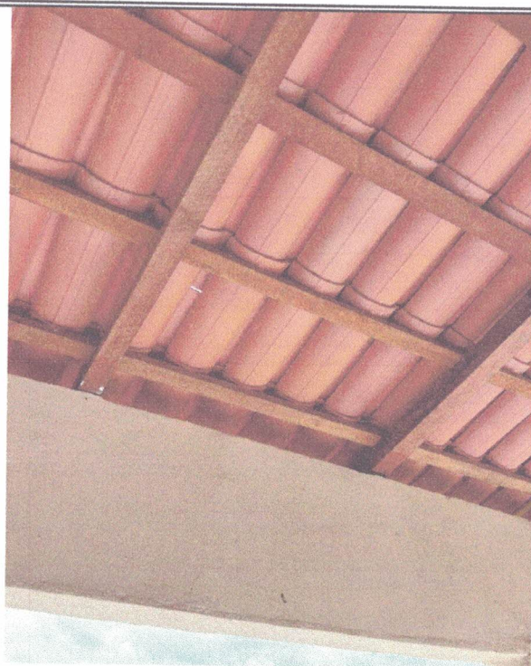
Foto 02- Vista do local que sera retelhado
