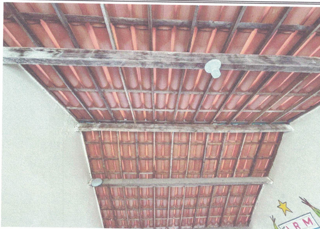
Foto 07 - Telhado danificado
