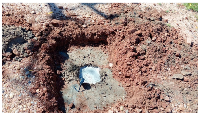
Figura 8 – Ensaio de infiltração 02.
