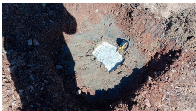
Figura 4 – Ensaio de infiltração 01.
