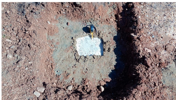
Figura 3 – Ensaio de infiltração 01.
