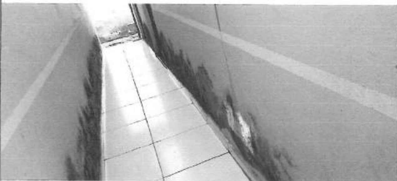
Figura 16 – CORREDOR ACESSO A LAVANDERIA
