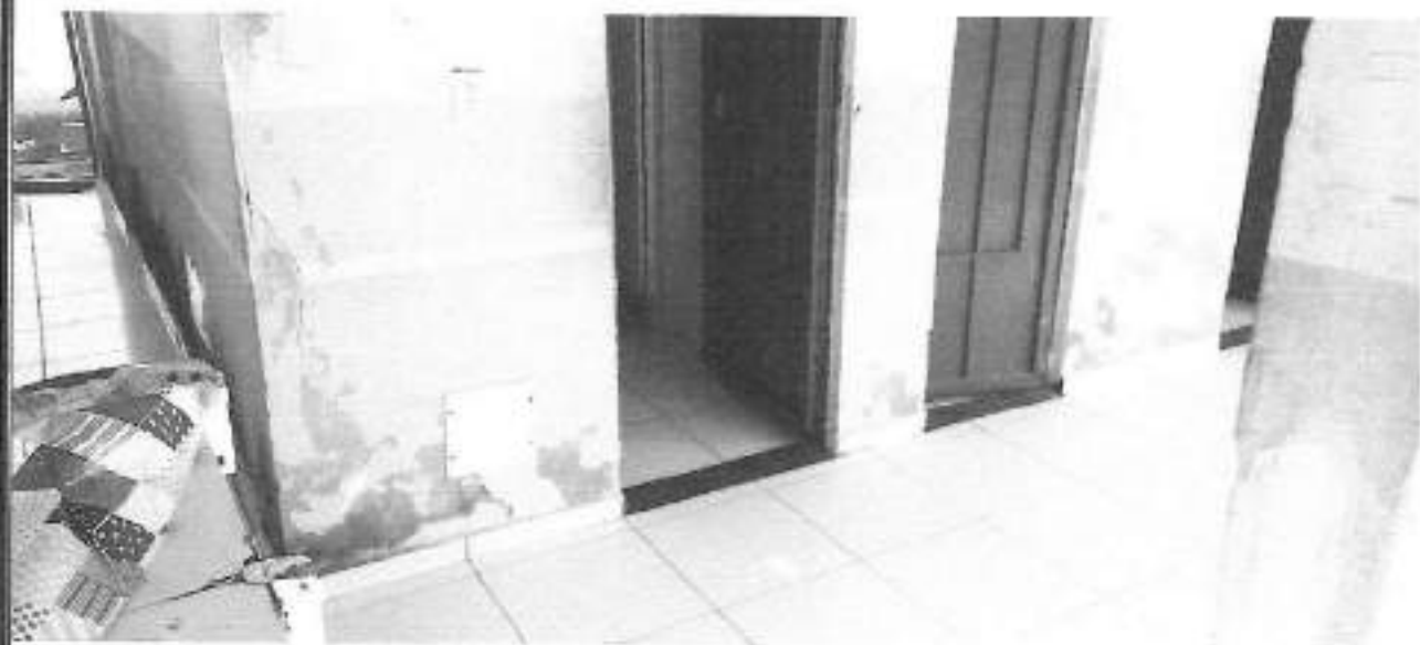
Figura 14 – ENTRADA DOS BANHEIROS
