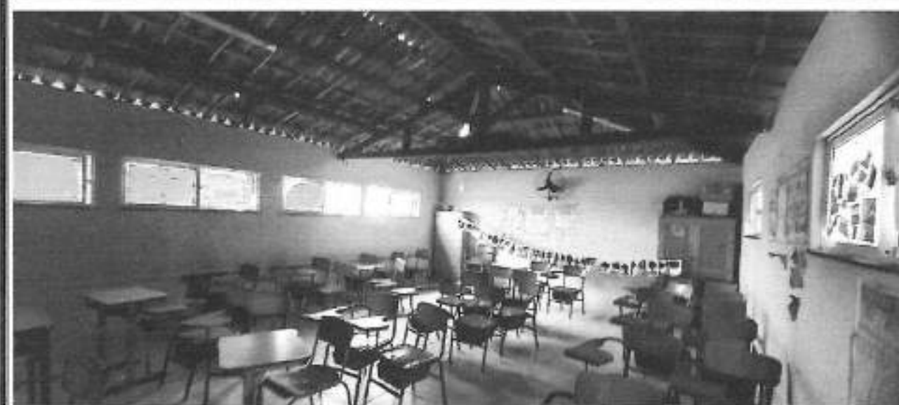
Figura 19 – COBERTA DE SALAS PARA RETELHAMENTO
