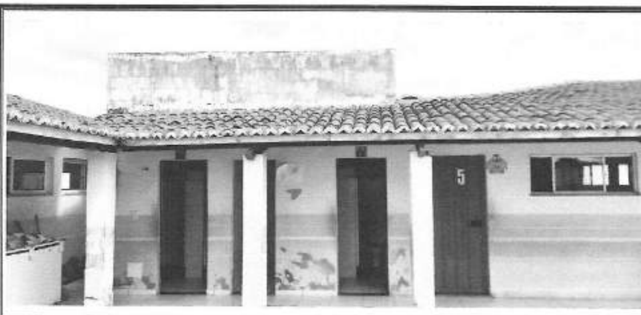
Figura 15 – FACHADA BANHEIROS E CAIXA D'ÁGUA
