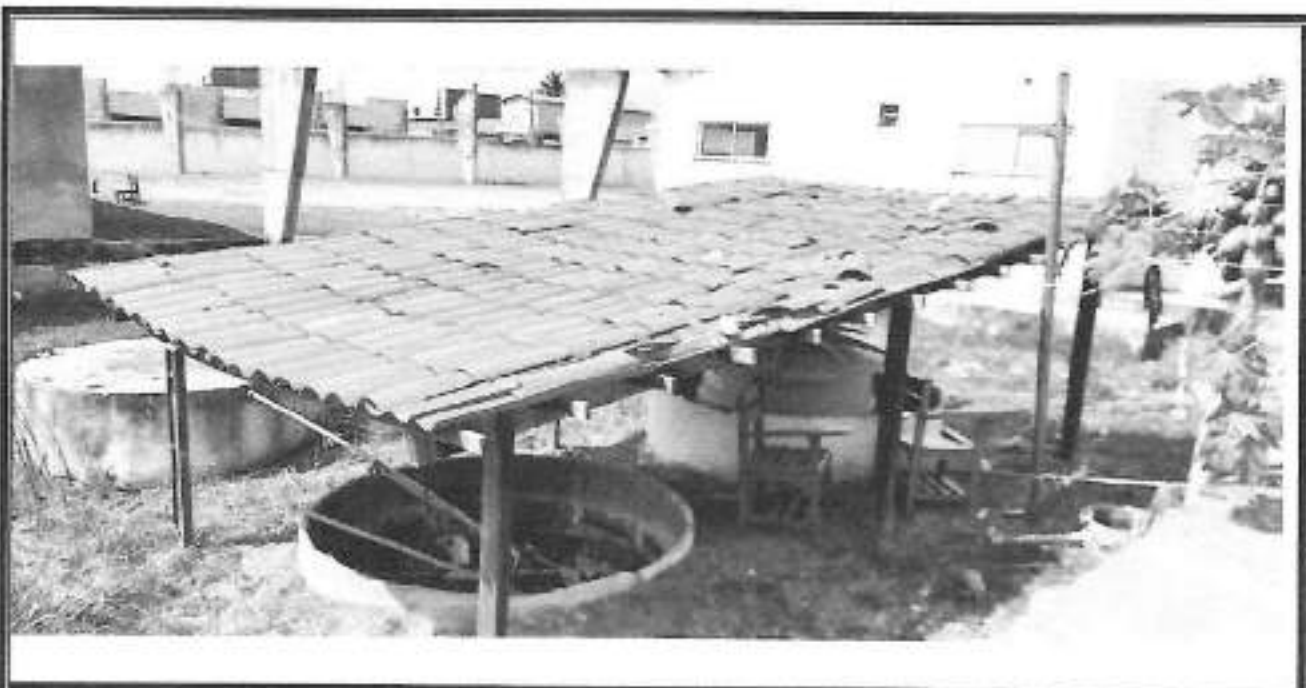
Figura 20 – COBERTA PARA DEMOLIR
