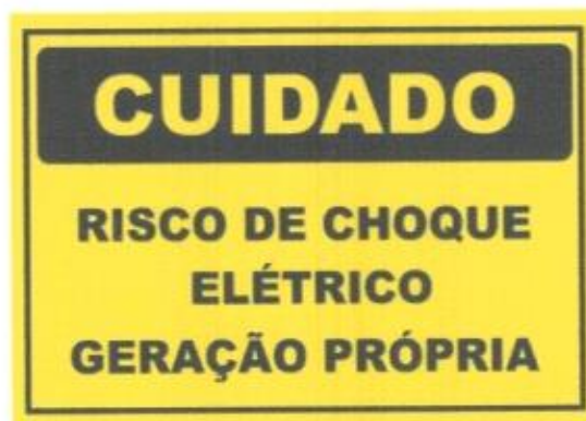
Figura 1 – Placa de advertência de geração própria
