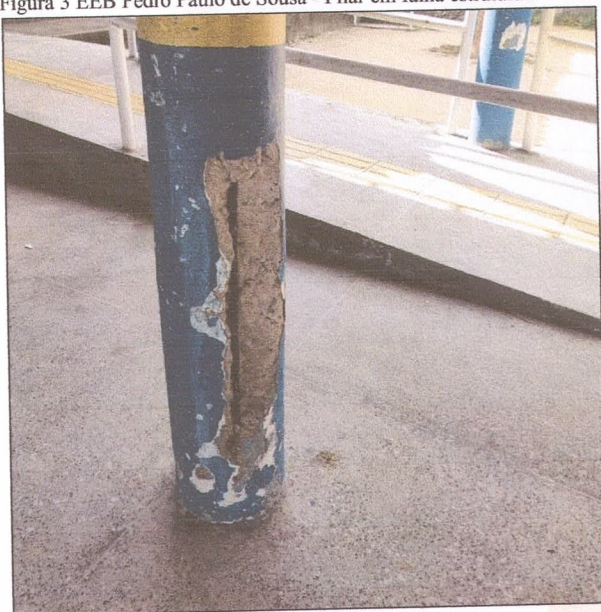
Figura 3 EEB Pedro Paulo de Sousa - Pilar em falha estrutural.
