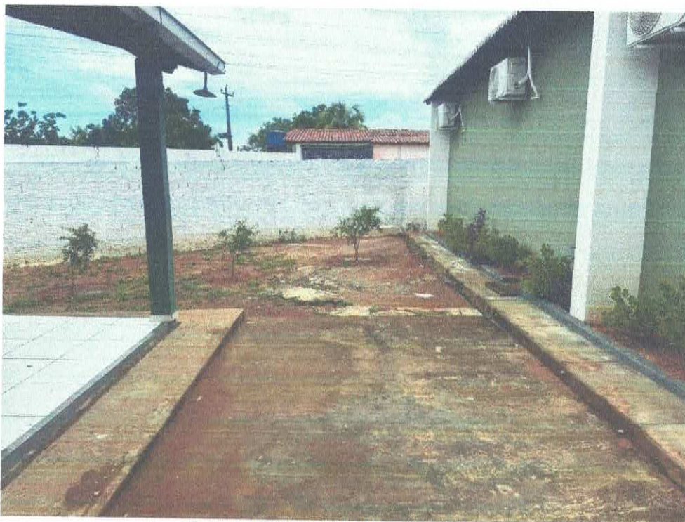
Figura 4 – ESPAÇO PARA RAMPA DE ACESSIBILIDADE
