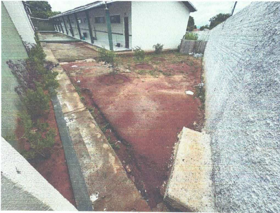
Figura 3 – AMPLIAÇÃO DO PÁTIO PARA ACESSO
