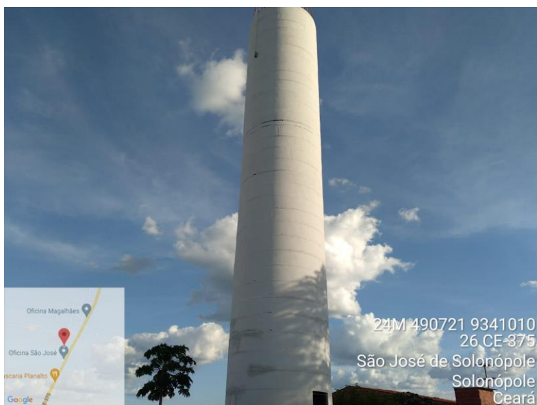
FIGURA 25 - RESERVATORIO ELEVADO EXISTENTE
