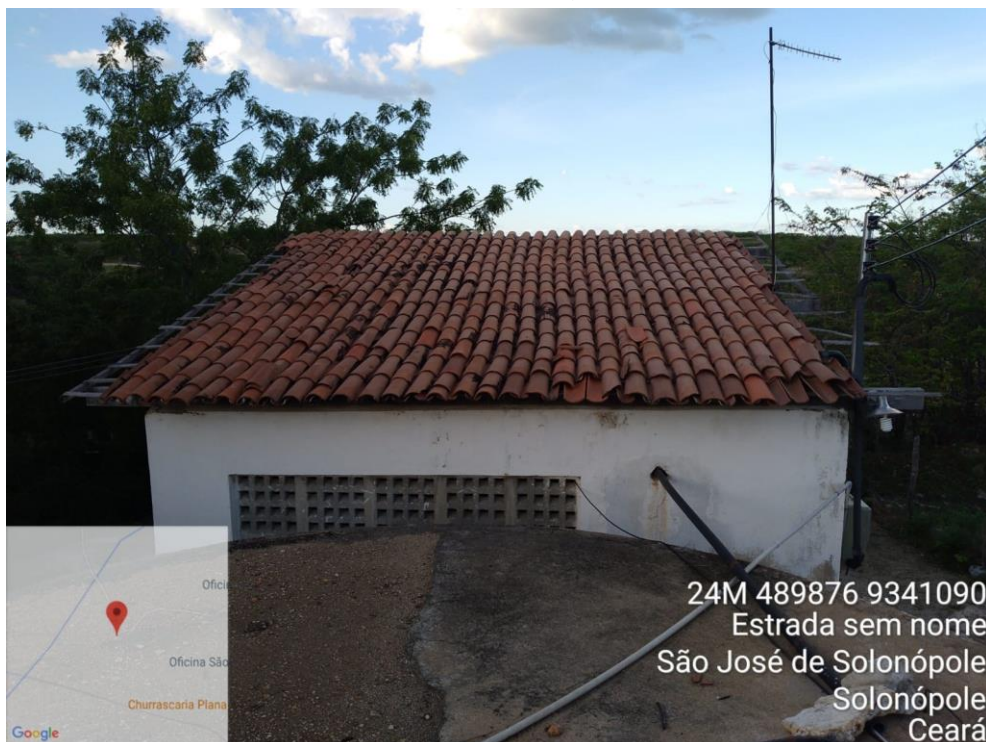
FIGURA 20 – RESERVATORIO APOIADO E ESTAÇÃO ELEVATORIA
