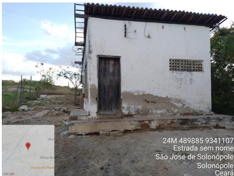
FIGURA 22 – ESTAÇÃO ELEVATORIA DA ETA
