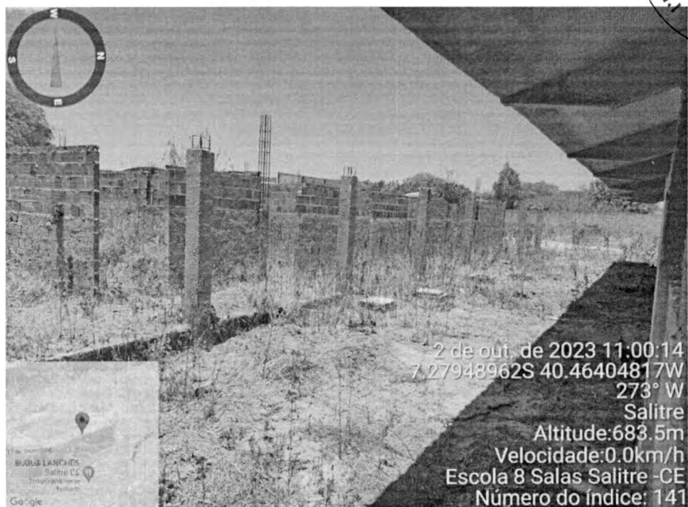
Figura 15: Vista da superestrutura do bloco administrativo.
