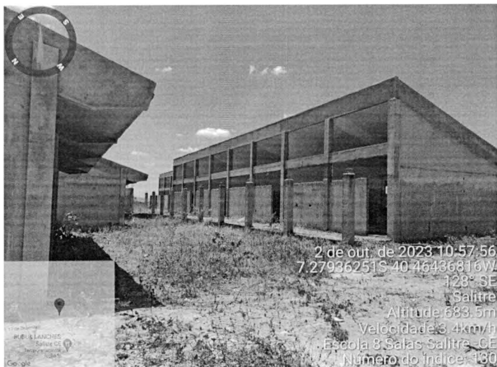
Figura 06: Vista dos laboratórios.
