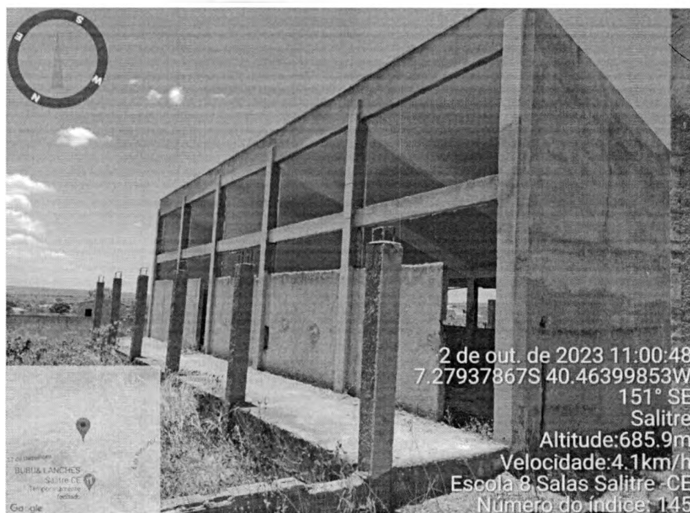
Figura 17: Vista do bloco de sala de aula.
