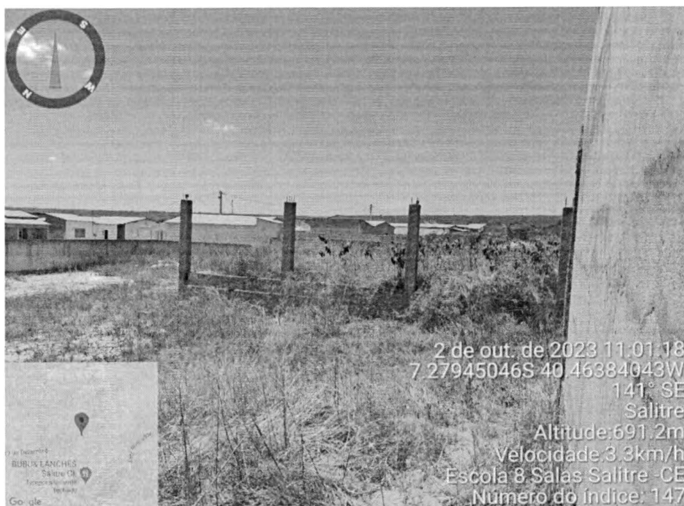
Figura 20: Vista da superestrutura do bloco de sala de aula.
