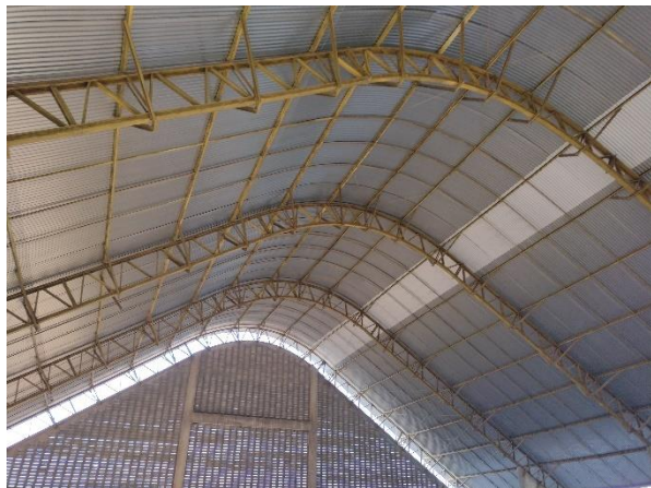
Figura 65 – Pintura executada na cobertura metálica;
