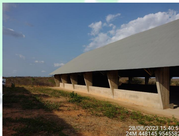
Figura 6 - Vista geral da obra;
