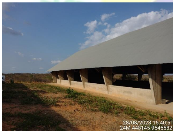
Figura 47 – Pilares e parte externa da arquibancada rebocada e chapiscadas;
