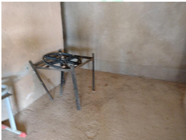
Figura 27 – Parede em bom estado e sem sinais de infiltração;
