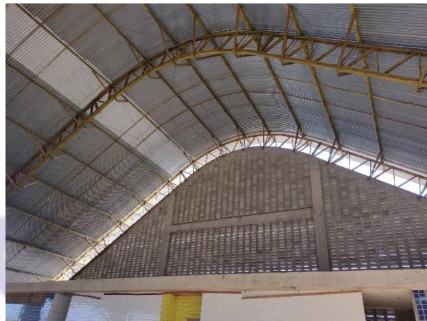
Figura 66 – Pintura executada na cobertura metálica;
