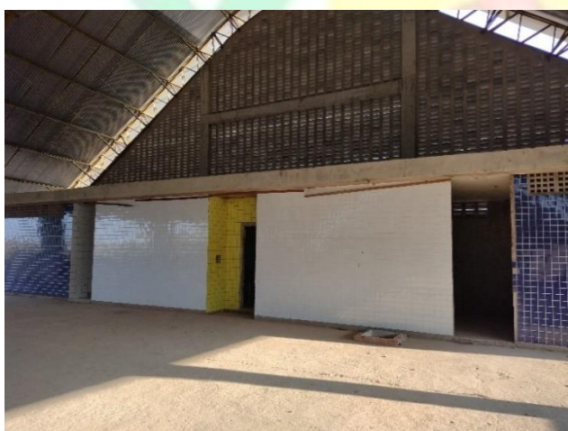
Figura 51 – Revestimento cerâmico em execução;
