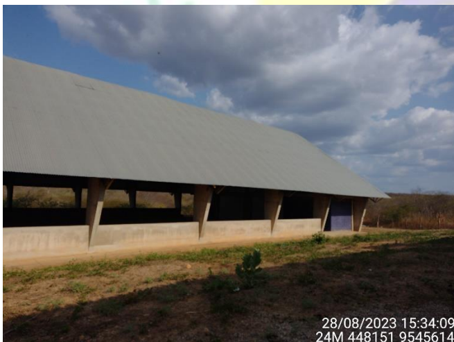
Figura 29 - Obra sem infiltração;
