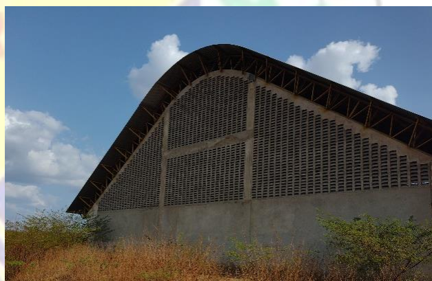
Figura 46 – Paredes já chapiscadas e rebocadas;
