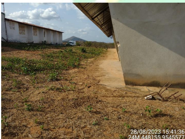
Figura 5 - Vista geral da obra;
