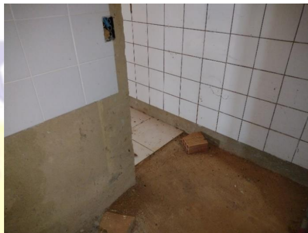
Figura 56 – Revestimento em sendo instalado no piso;
