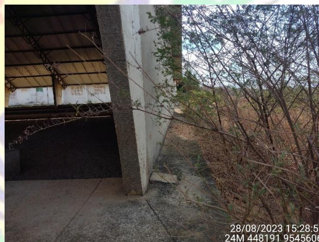
Figura 64 – Piso externo executado com qualidade;
