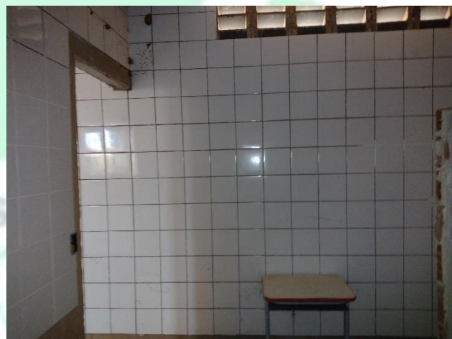
Figura 34 - Porta de acesso aos chuveiros e sanitários com verga e complemento em alvenaria em bom estado e sem trincas;
