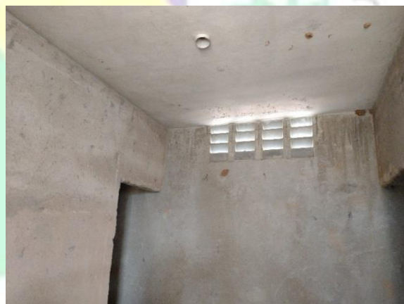
Figura 48 – Paredes e laje já chapiscadas e rebocadas;
