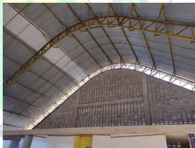
Figura 38 – Cobertura com suas devidas alterações;
