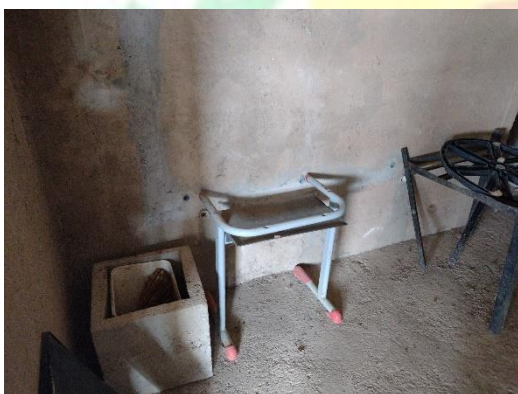
Figura 45 – Paredes já chapiscadas e rebocadas;
