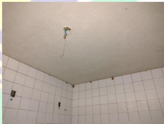
Figura 20 - Laje, pilares e vigas executados e sem nenhum tipo de manifestação patológica;
