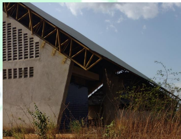
Figura 26 - Fixação metálica entre os pilares trapezoidais e a cobertura metálica;
