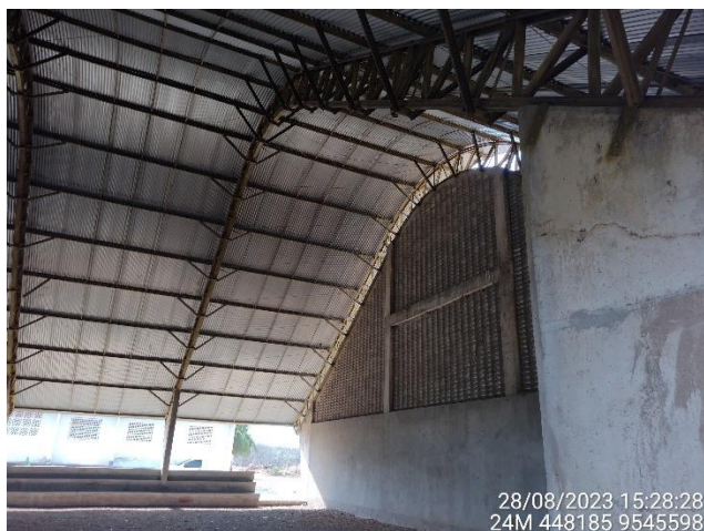
Figura 39 – CX1 a CX4 executados divergente;
