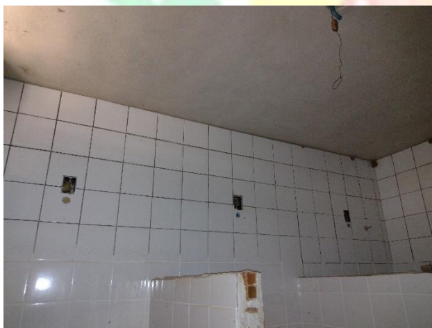
Figura 70 – Instalações hidráulicas e elétricas embutidas e sendo executadas;
