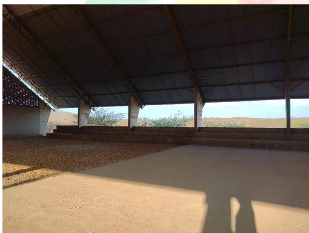
Figura 23 - Pilares trapezoidais executados e em bom estado;
