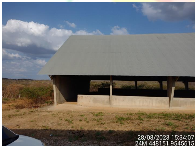
Figura 3 - Vista geral da obra;
