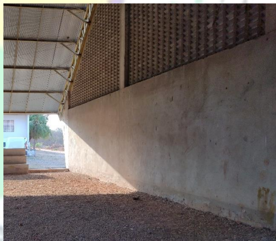
Figura 30 - Obra sem infiltração;
