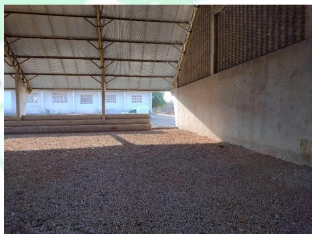
Figura 60 - Piso da quadra ainda sem contrapiso;
