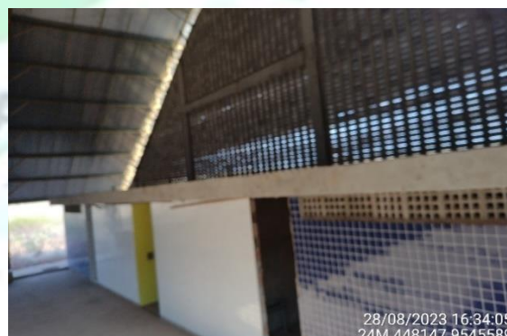
Figura 44 – Abertura para instalação das bandeiras de madeira acima das portas de acesso aos vestiários executada e aguardando esquadria;
