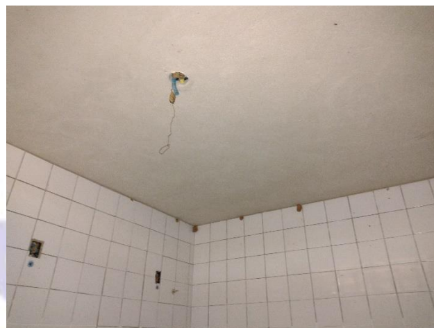
Figura 32 - Laje sem infiltração;
