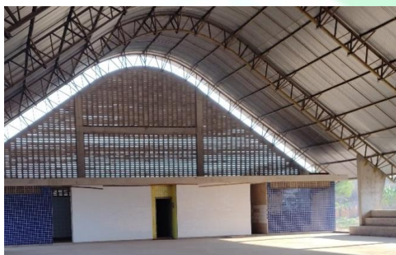
Figura 43 – Abertura para instalação das bandeiras de madeira acima das portas de acesso aos vestiários executada e aguardando esquadria;
