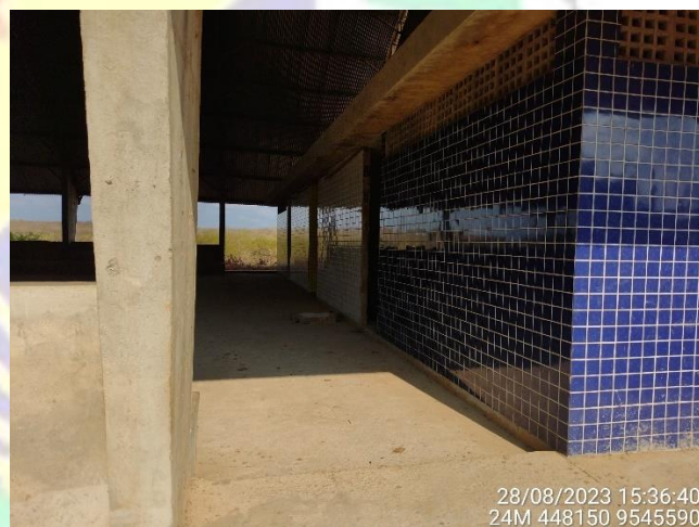
Figura 24 - Laje, pilares e vigas executados e sem nenhum tipo de manifestação patológica;
