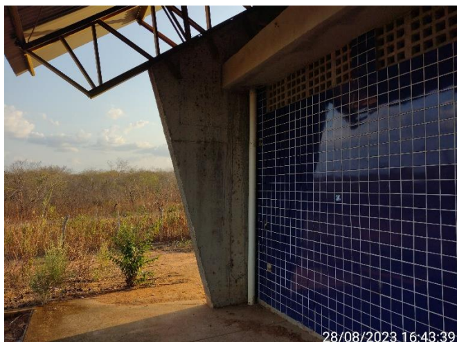
Figura 74 – Descida de Instalações Pluviais executada;
