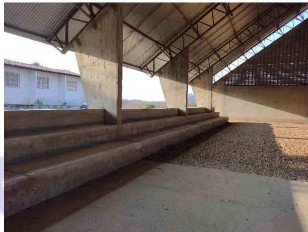
Figura 50 – Arquibancada em bom estado;
