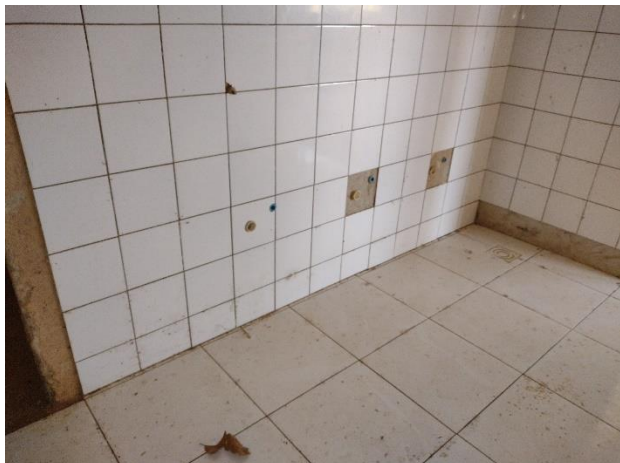
Figura 68 – Instalações hidráulicas e sanitárias embutidas e sendo executadas;
