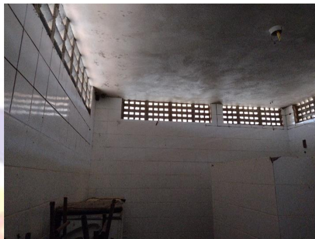
Figura 18 – Laje, pilares e vigas executados e sem nenhum tipo de manifestação patológica;
