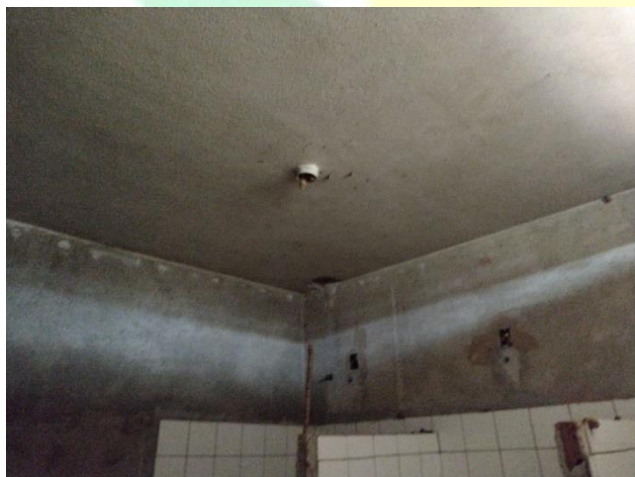
Figura 19 - Laje, pilares e vigas executados e sem nenhum tipo de manifestação patológica;
