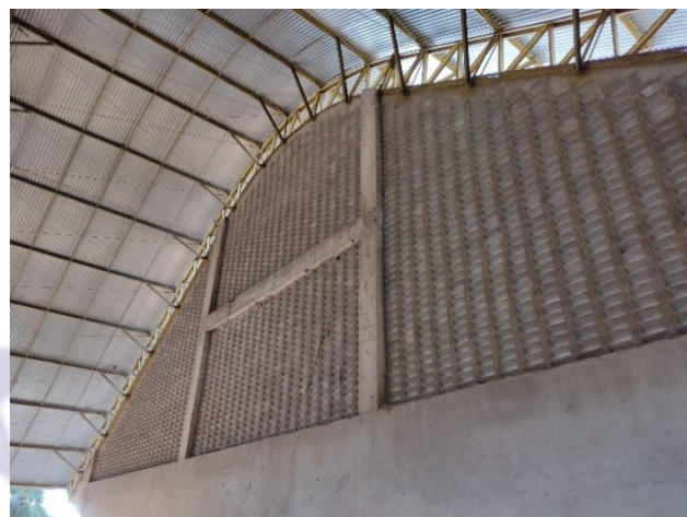
Figura 22 - Pilares e vigas executados e em bom estado;
