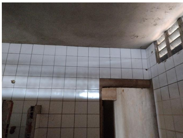
Figura 35 – Parede divisória executada até o teto intacta;
