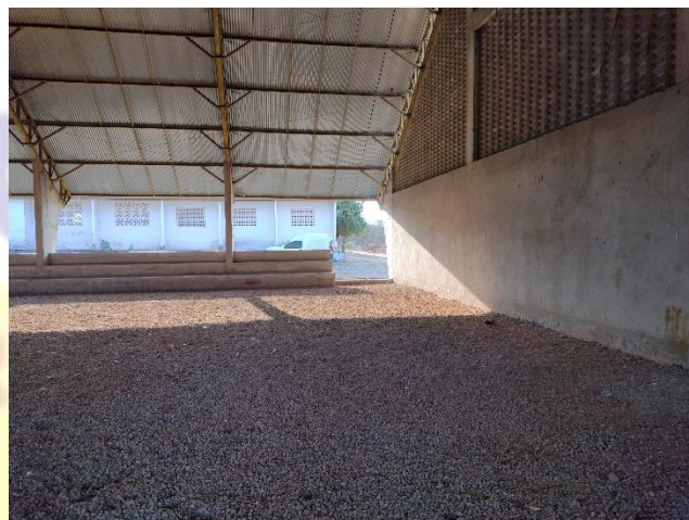
Figura 14 - Obra em estágio avançado, sem possibilidade de visualização de fundação. Ausência de manifestações patológicas ou anomalias;
