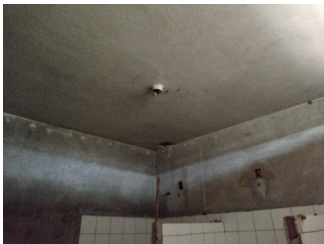
Figura 31 - Laje sem infiltração;
