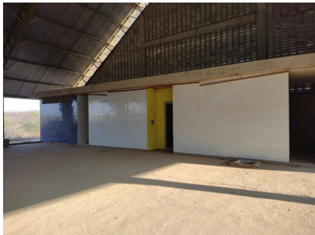
Figura 61 – Piso da quadra parcialmente executado com contrapiso;
