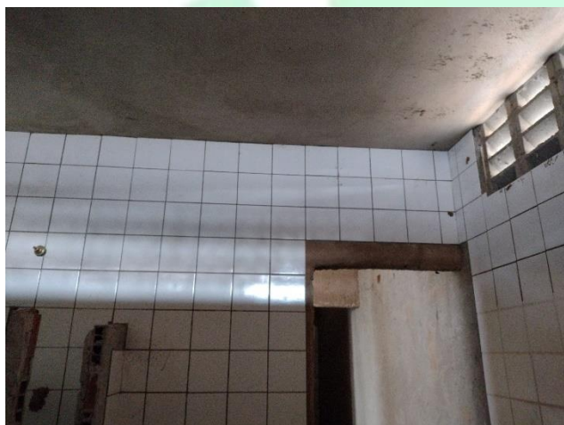
Figura 33 – Porta de acesso aos chuveiros e sanitários com verga e complemento em alvenaria em bom estado e sem trincas;
