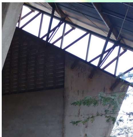
Figura 25 - Fixação metálica entre os pilares trapezoidais e a cobertura metálica;
