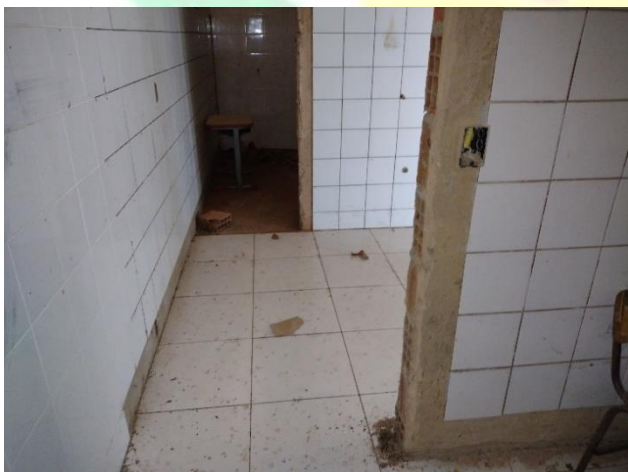
Figura 57 – Revestimento em sendo instalado no piso;
