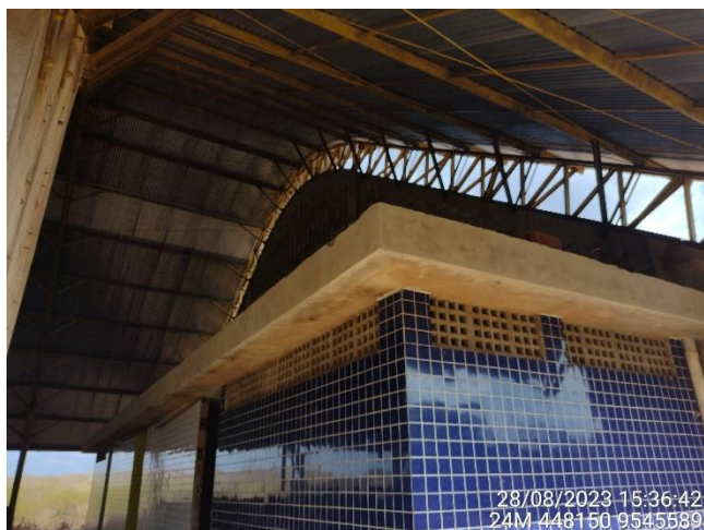
Figura 21 - Laje, pilares e vigas executados e sem nenhum tipo de manifestação patológica;
