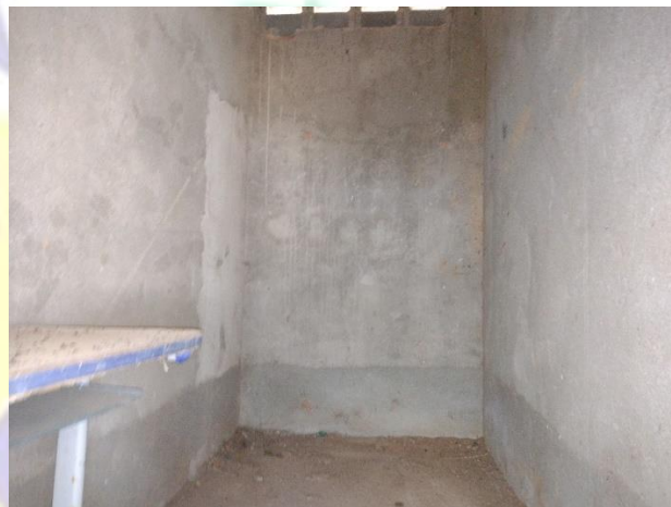
Figura 28 – Parede em bom estado e sem sinais de infiltração;
