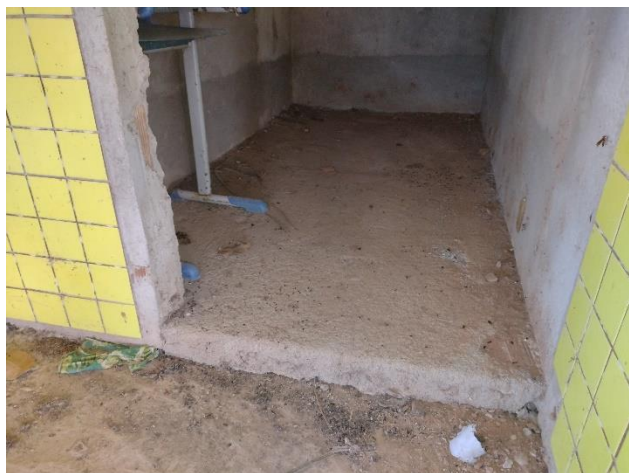
Figura 13 - Obra em estágio avançado, sem possibilidade de visualização de fundação. Ausência de manifestações patológicas ou anomalias;
