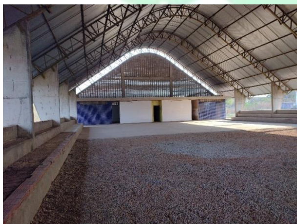
Figura 59 – Piso da quadra parcialmente executado com contrapiso;
