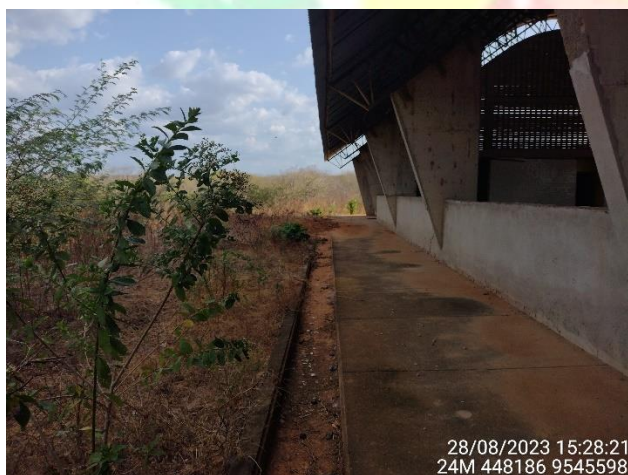
Figura 63 – Piso externo executado com qualidade;
