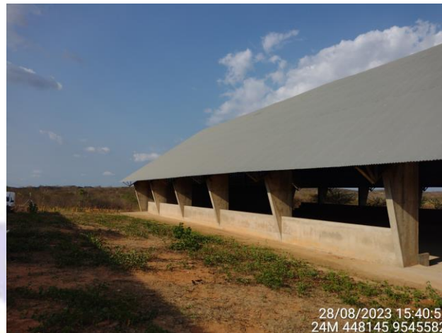
Figura 62 – Piso externo executado com qualidade;
