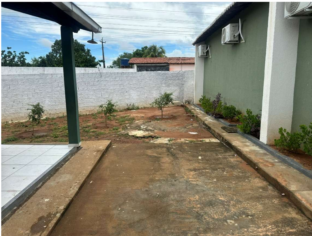
Figura 4 – ESPAÇO PARA RAMPA DE ACESSIBILIDADE
