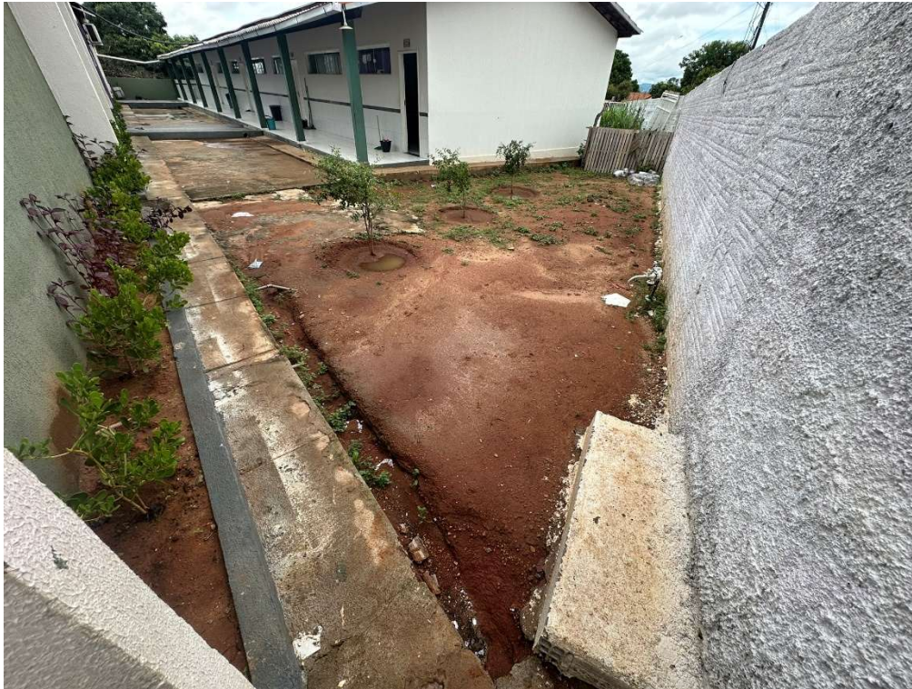
Figura 3 – AMPLIAÇÃO DO PÁTIO PARA ACESSO
