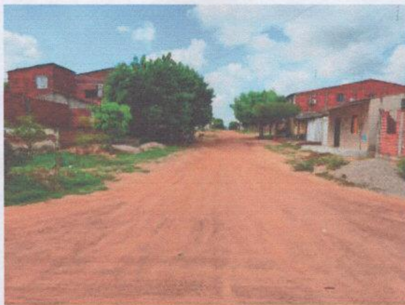
FIM DA RUA AGOSTINHO GONÇALVES A SER PAVIMENTADO E(X) 612.057.93m,N(Y) 9.438.467.59m,E
