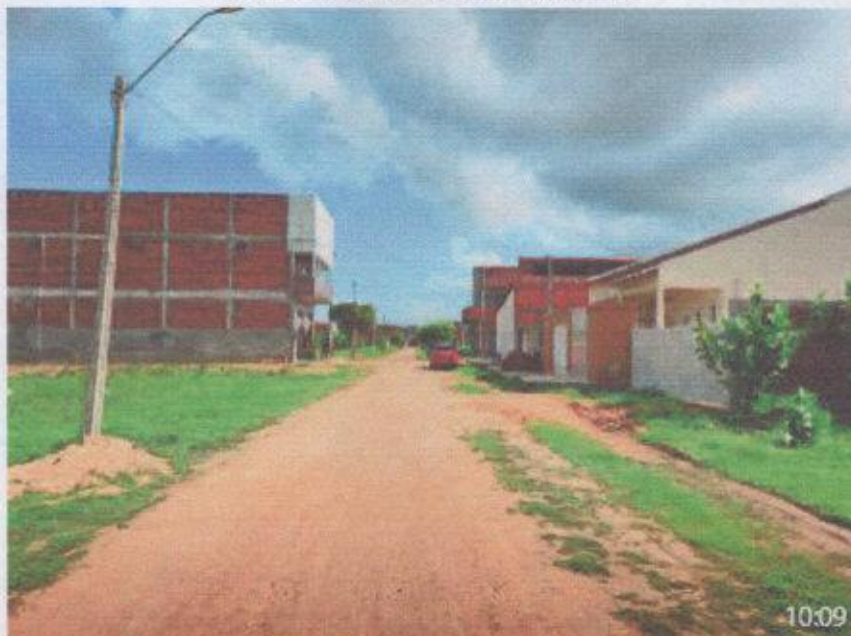
INÍCIO DA RUA JOAQUIM MARTINS DA SILVA A SER PAVIMENTADO E(X) 611.338.65m ,N(Y) 9.438.846.01m,E
