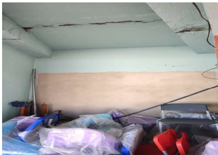
FOTO 18 – LOCAL DA INSTALAÇÃO DA PORTA 01
