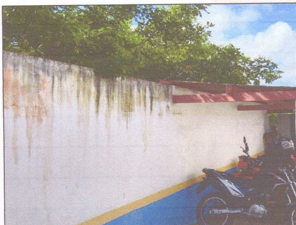
Figura 4: EEB Maria das Mercês Gomes - Infiltração interna.
