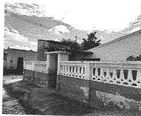
FOTO 04- FACHADA EXTERNA PRINCIPAL
