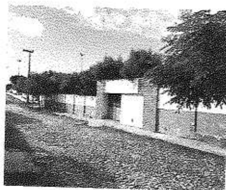
FOTO 01- FACHADA EXTERNA PRINCIPAL
