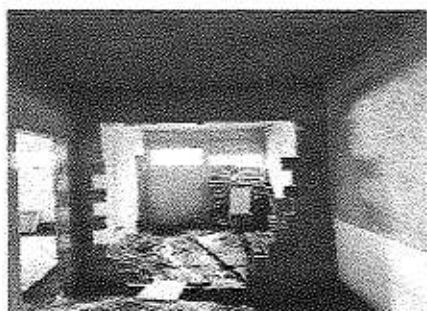
FOTO 47- ÁREA DE SERVIÇO
