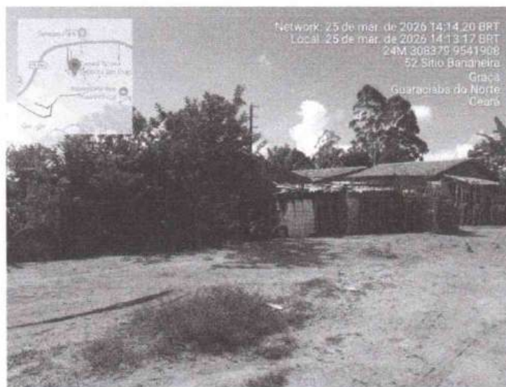
FOTO 04: Vista lateral Oeste.
