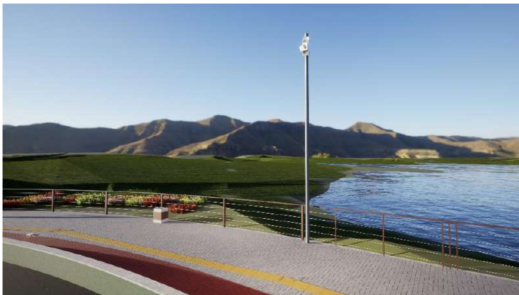
Figura 20 – Projetores (100W) acoplados em poste flangeado cônico de 6m
