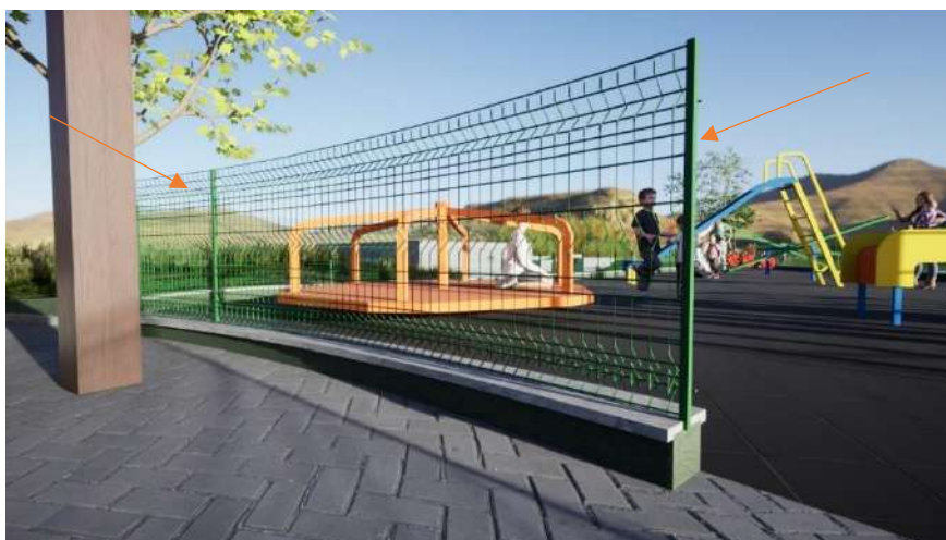
Figura 29 – Gradil Nylofor fixado na mureta em alvenaria.
