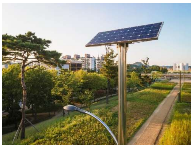
Figura 17 – Exemplo de postes com luminárias solares
