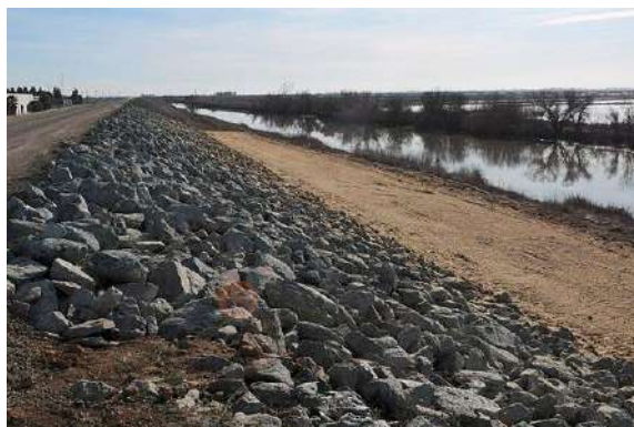
Figura 16 – Exemplo de enrocamento com pedra jogada
