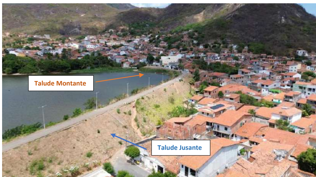
Figura 15 – Vista da Barragem da nação
