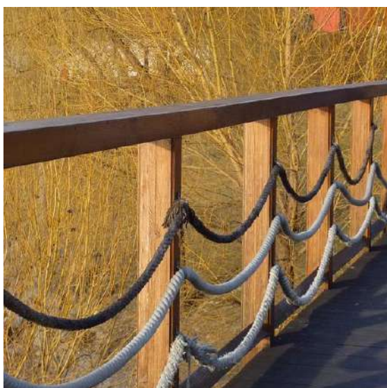
Figura 27 – Guarda-corpo com corrimão em madeira e aço.
