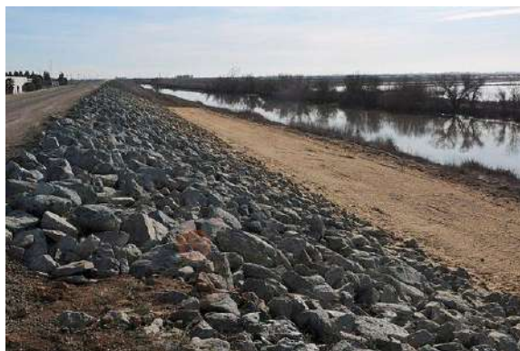
Figura 16 – Exemplo de enrocamento com pedra jogada
