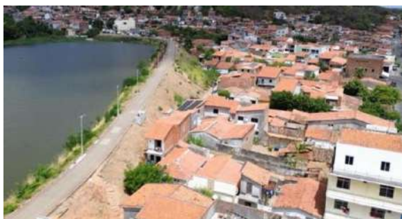
Figura 7 – Talude sem proteção vegetal.
