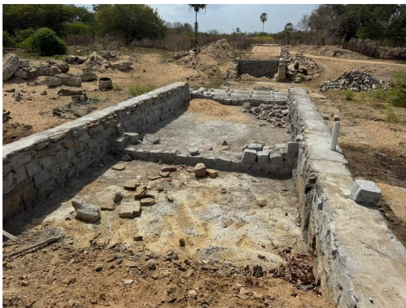
Figura 05 – PASSAGEM MOLHADA LATITUDE: 9423828.36 E / LONGITUDE: 579683.14 S
