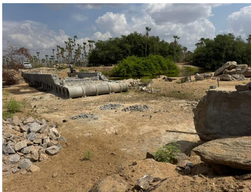
Figura 02 – PASSAGEM MOLHADA LATITUDE: 9423841.47 E / LONGITUDE: 579654.28 S
